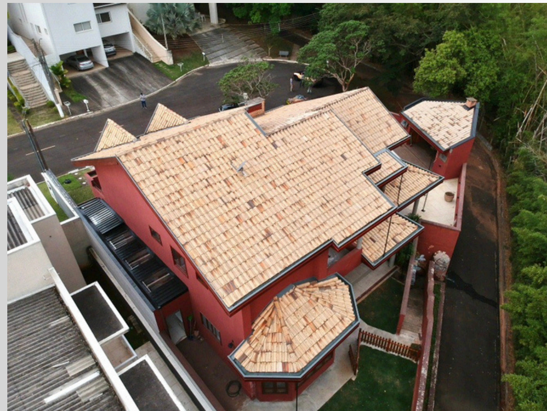
Reforma de telhado - Telhas Coloniais Portuguesas Mesclada
