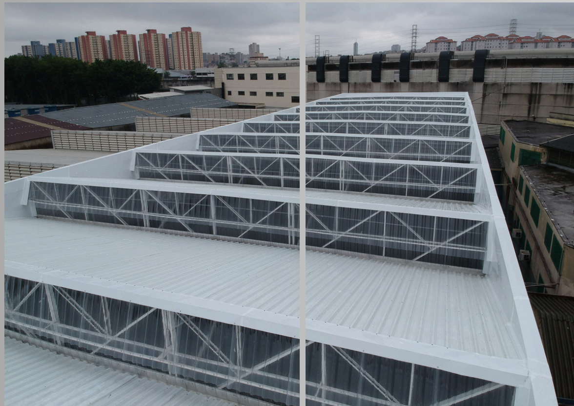
Substituição de telhado - Telhas Metálicas Sanduíche trp40/980
