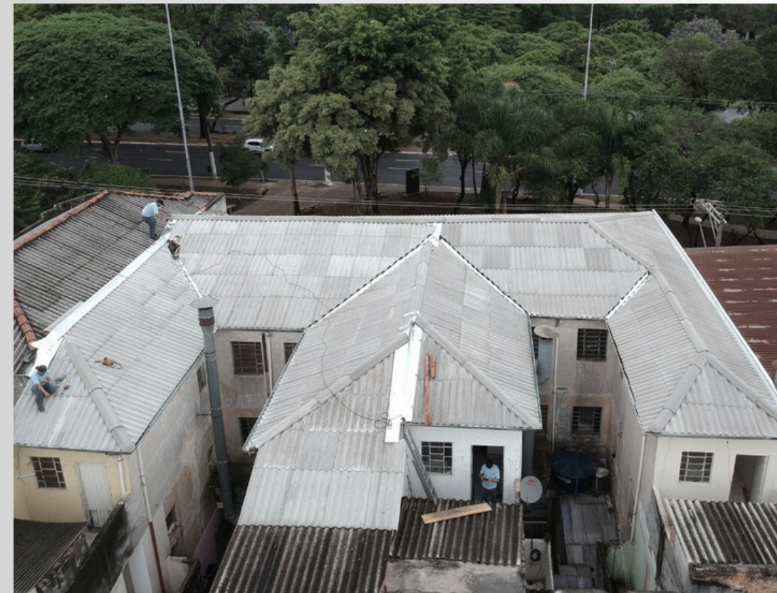
Substituição de Telhado - Telha fibrocimento Brasilit 6mm
