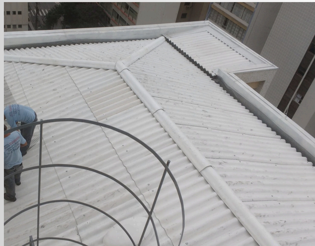
Substituição de Telhado - Telha fibrocimento Brasilit Top Comfort 6mm
