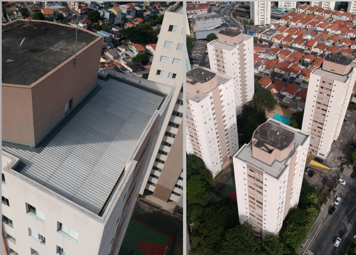
Substituição de Telhado - Telhas Brasilit fibrocimento 8mm (Blocos 1, 3 e 4)
