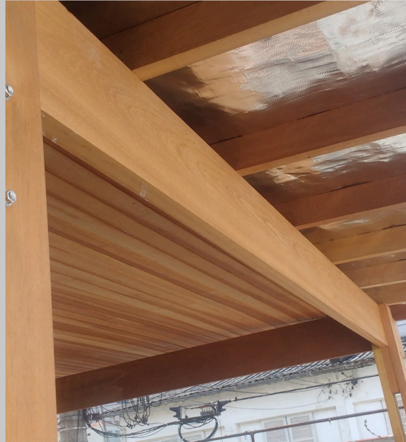
Forração pela parte inferior das vigas
