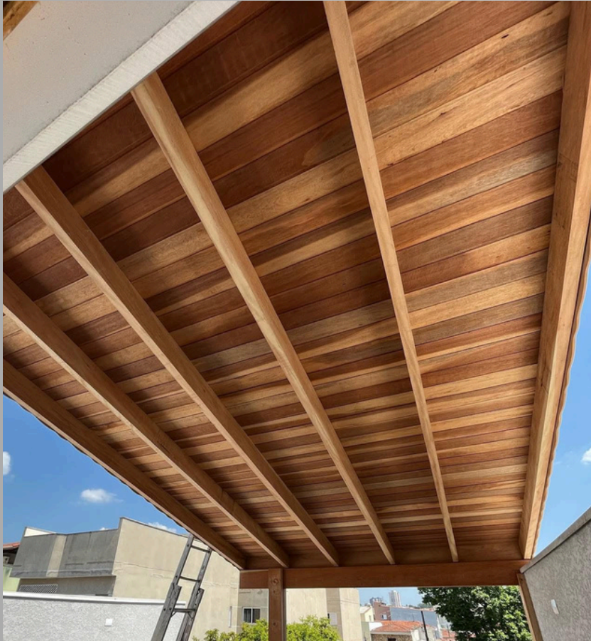
Forração pela parte superior das vigas
