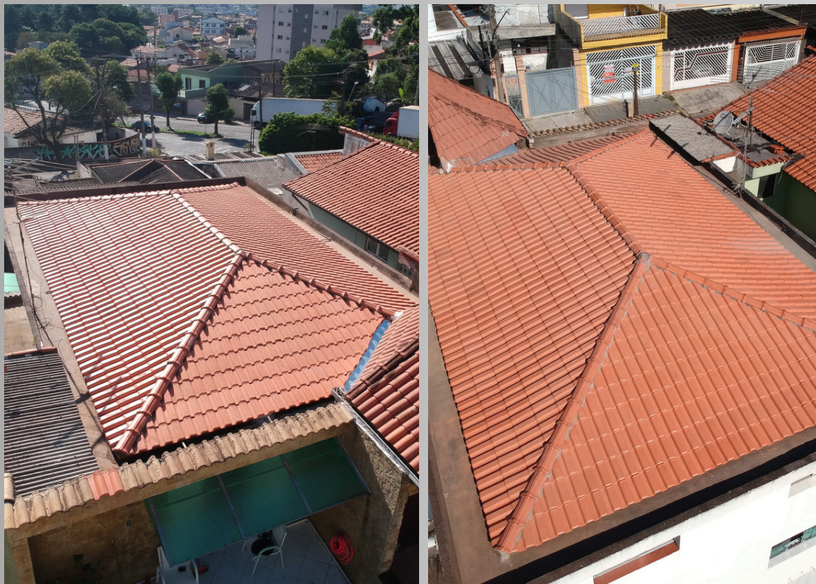
Substituição de Telhado - Telha fibrocimento Brasilit 6mm (com resina)
