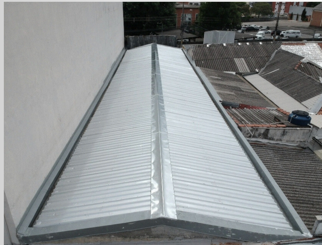
Substituição de telhado - Telhas Metálicas trp40/980 folha simples
