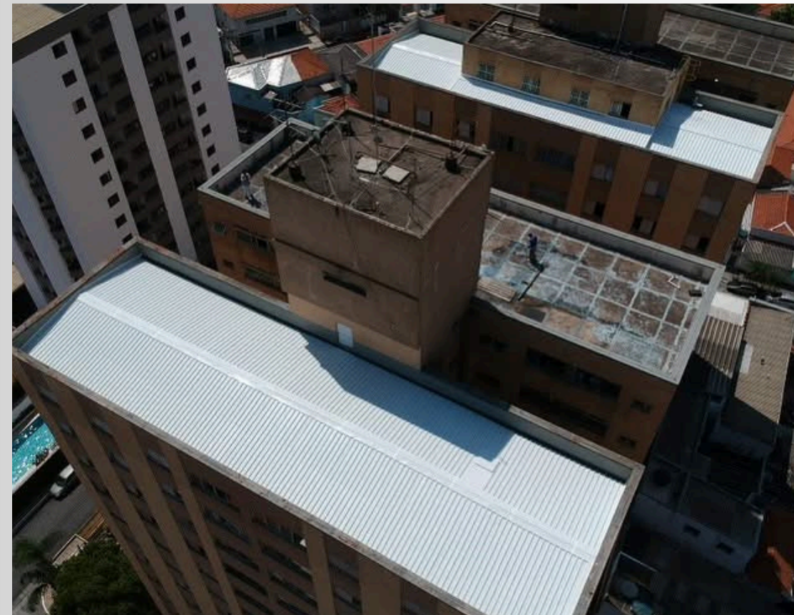
Substituição de Telhado - Telha Galvalume Sanduíche EPS 30mm
