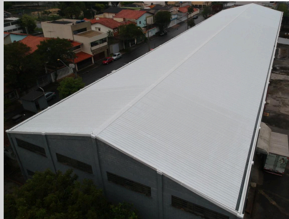
Substituição de telhado - Telhas Metálicas Simples trp40/980
