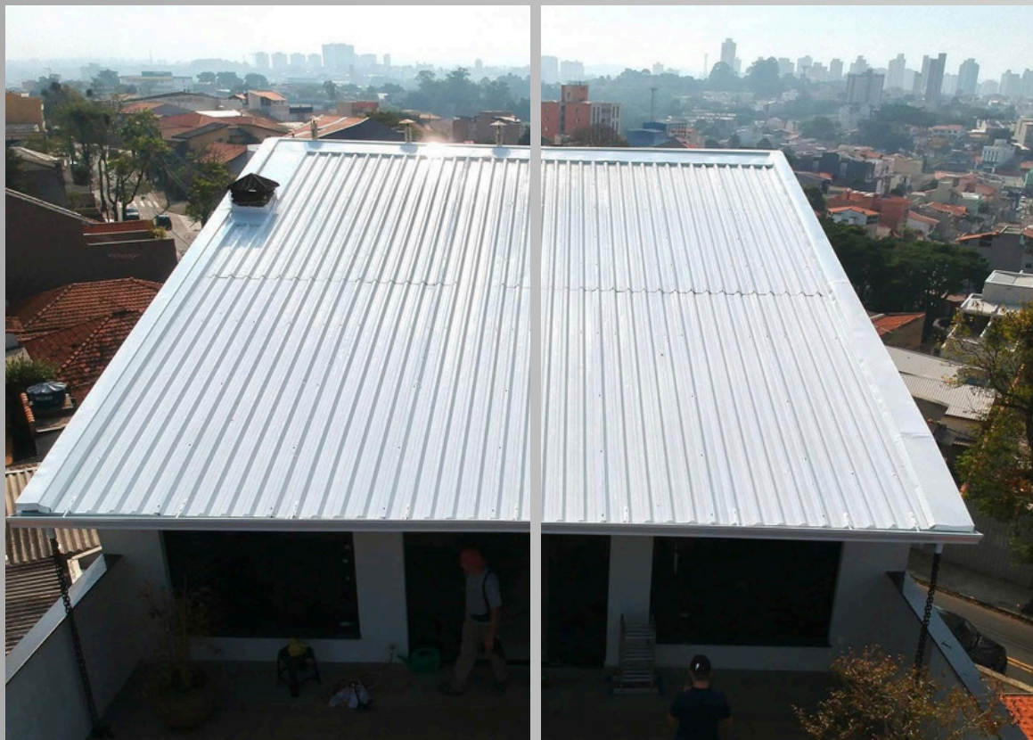
Substituição de Telhado - Sanduíche PU trp40/980
