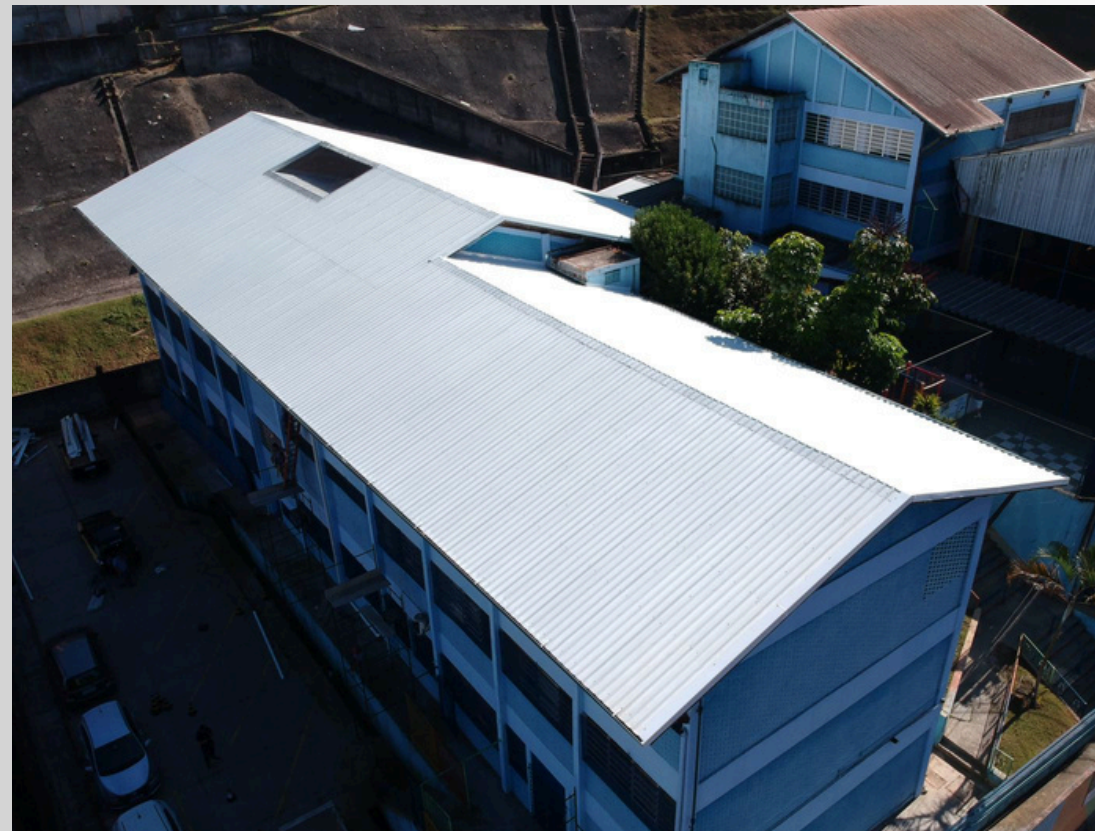
Substituição de telhado - Telhas Metálicas Sanduíche trp40/980
