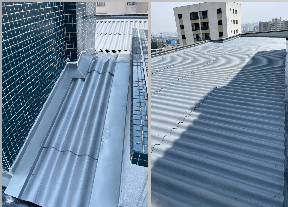
Reforma de Telhado - Telha fibrocimento 6mm
