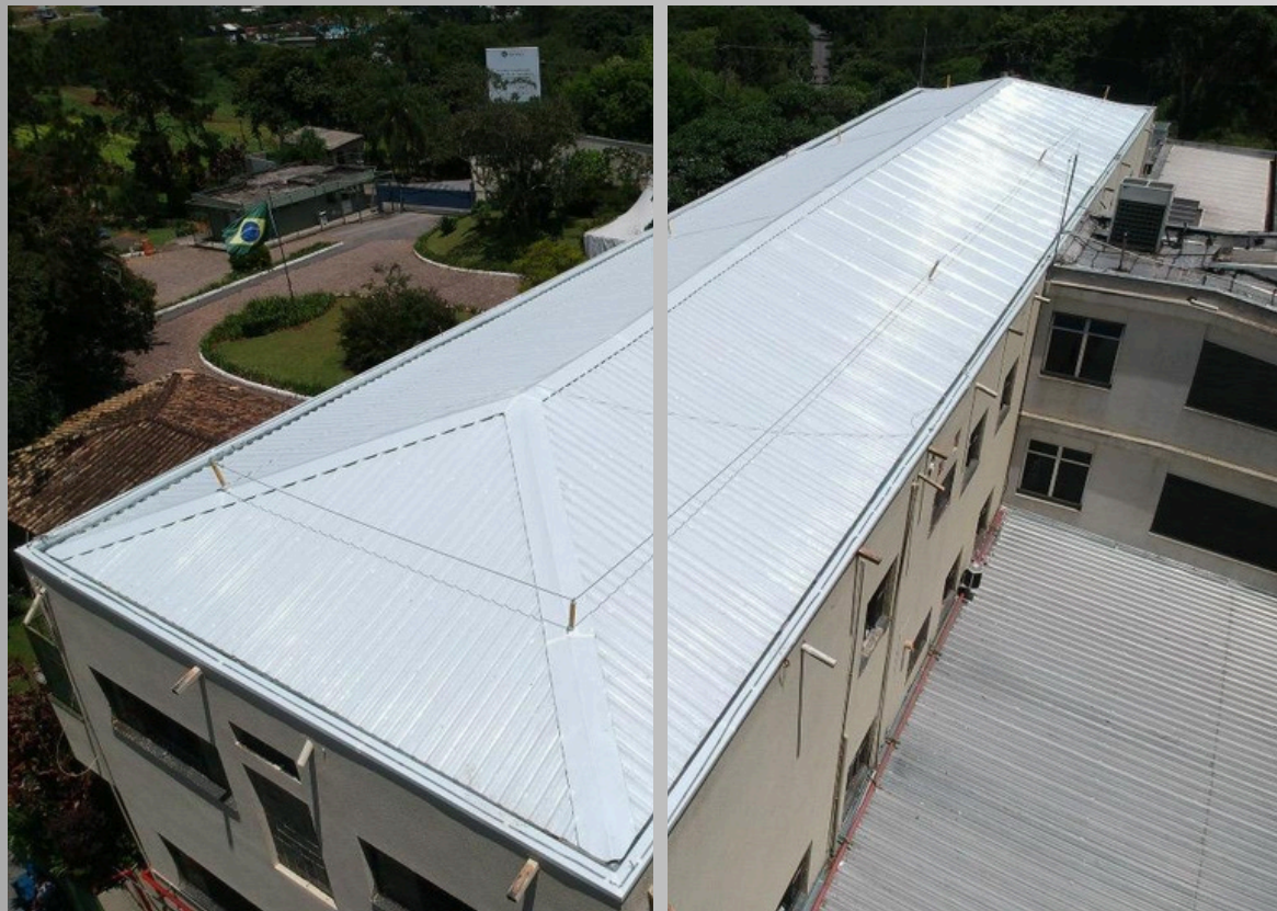
Substituição de telhado - Telhas Metálicas Sanduíche trp40/980
